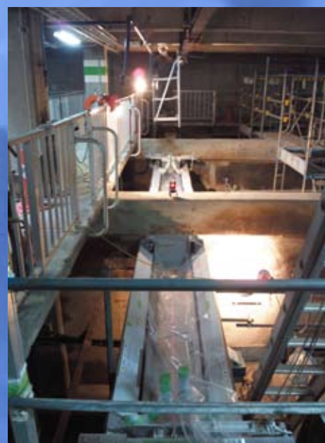
処理場更新工事
