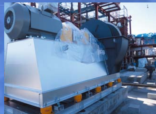
排風機据付工事
