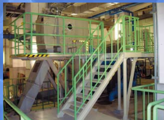
処理場修繕工事
